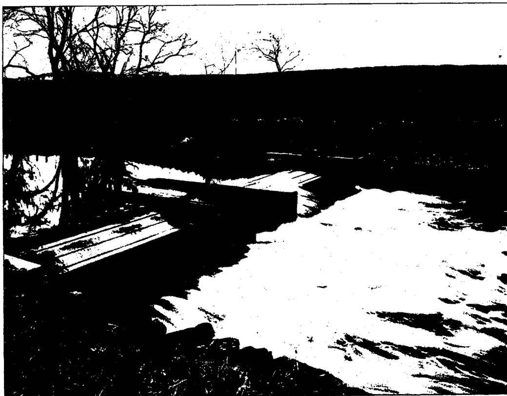
Figur 9 Terskel for telling av fisk med Logie Fish Counter i West Water, en sideelv til river North Esk. Fra Scottish Office Agriculture and Fisheries Departement (1991).
